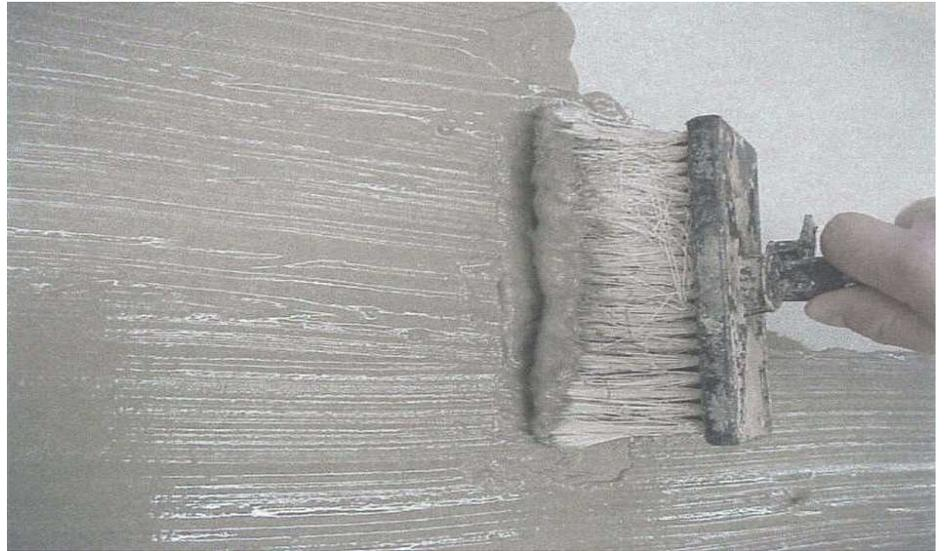
**Wichtig:** Die maximale Stärke frischer Abdichtungen mit Bauseal 1114 beträgt 5 mm. Sie darf keinesfalls überschritten werden. Frische, noch nicht abgebundene Beschichtungen sind regen- und frostempfindlich.
