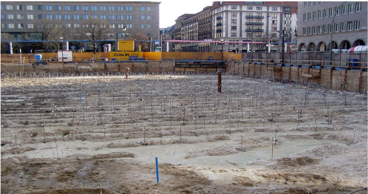
Bodenversiegelung mit PURSEAL 912
